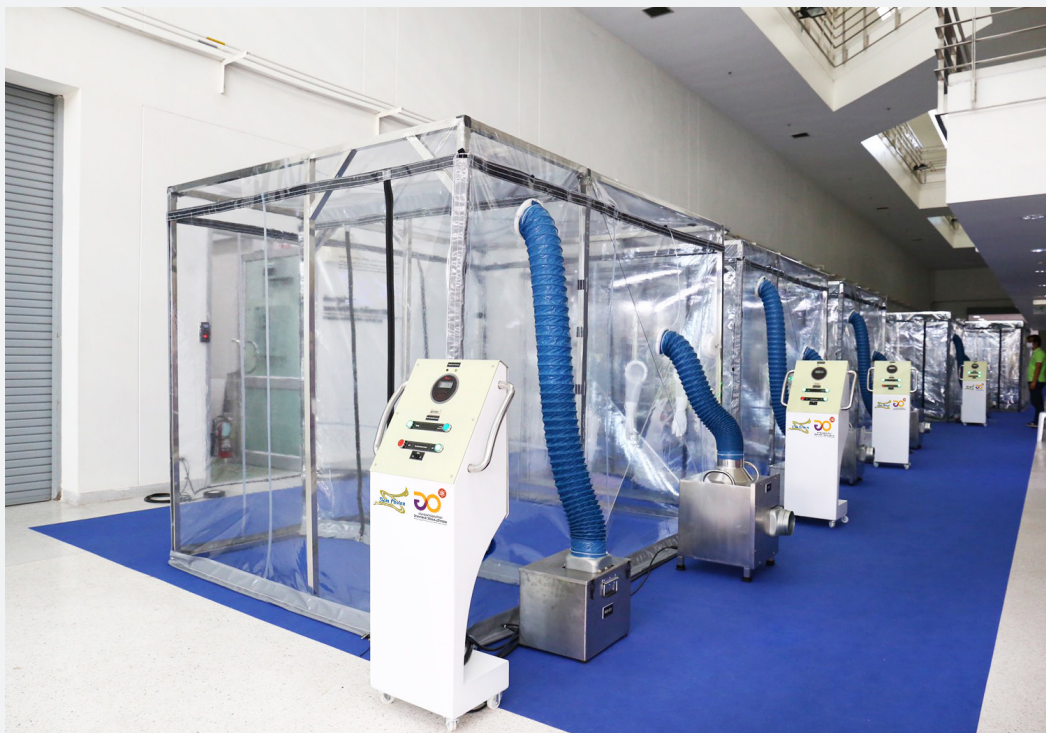
รูปที่ 5 ต้นแบบห้องแยกโรคความดันลบ สำหรับโรงพยาบาลสนาม
